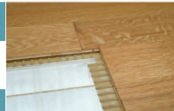
Pavimento in legno da 10 mm posato ed incollato su "FIDE".
