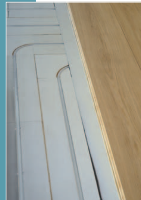
Particolare con impianto "FIDE" installato, con materasso e pavimento in legno posato flottante.
